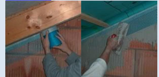
Es wird mit Klebepunkten am Mauerwerk "angeheftet". Das Trennpapier auf dem CONTEGA Band wird entfernt und die Dampfbremse auf dem Klebestreifen angeschlossen. Der Gipser/Stuckateur bettet das Armierungsgewebe in seinen Putz ein. Die Dampfbremse ist damit dauerhaft luftdicht an das Mauerwerk angeschlossen.
