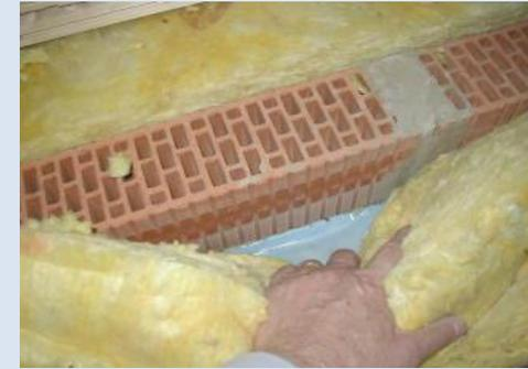
Eine Innenwand in einem EFH aus Lochziegeln ist nach oben zum unausgebauten Spitzboden offen.
