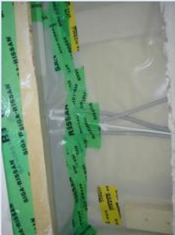
Einen Durchbruch von Kabeln und Versorgungsleitungen sollte man möglichst vermeiden. Man muss die Dauerbelastung der Klebung durch das Gewicht der Kabel berücksichtigen!
