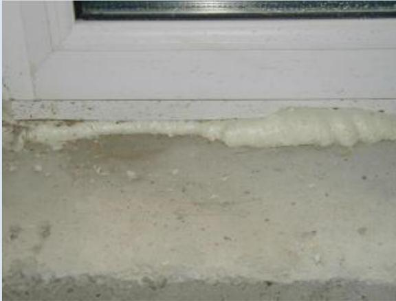
Oftmals wird das Fenster einfach mit Bauschaum eingesetzt und angeputzt. Bauschaum ist aber weder diffusionsdicht noch luftdicht. Es ist ein luftdichter u. diffusionsdichter Anschluss, z. B. Folien erforderlich.
